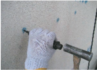
グラウトピン打込み
